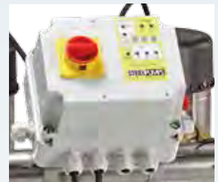
Quadro di comando
